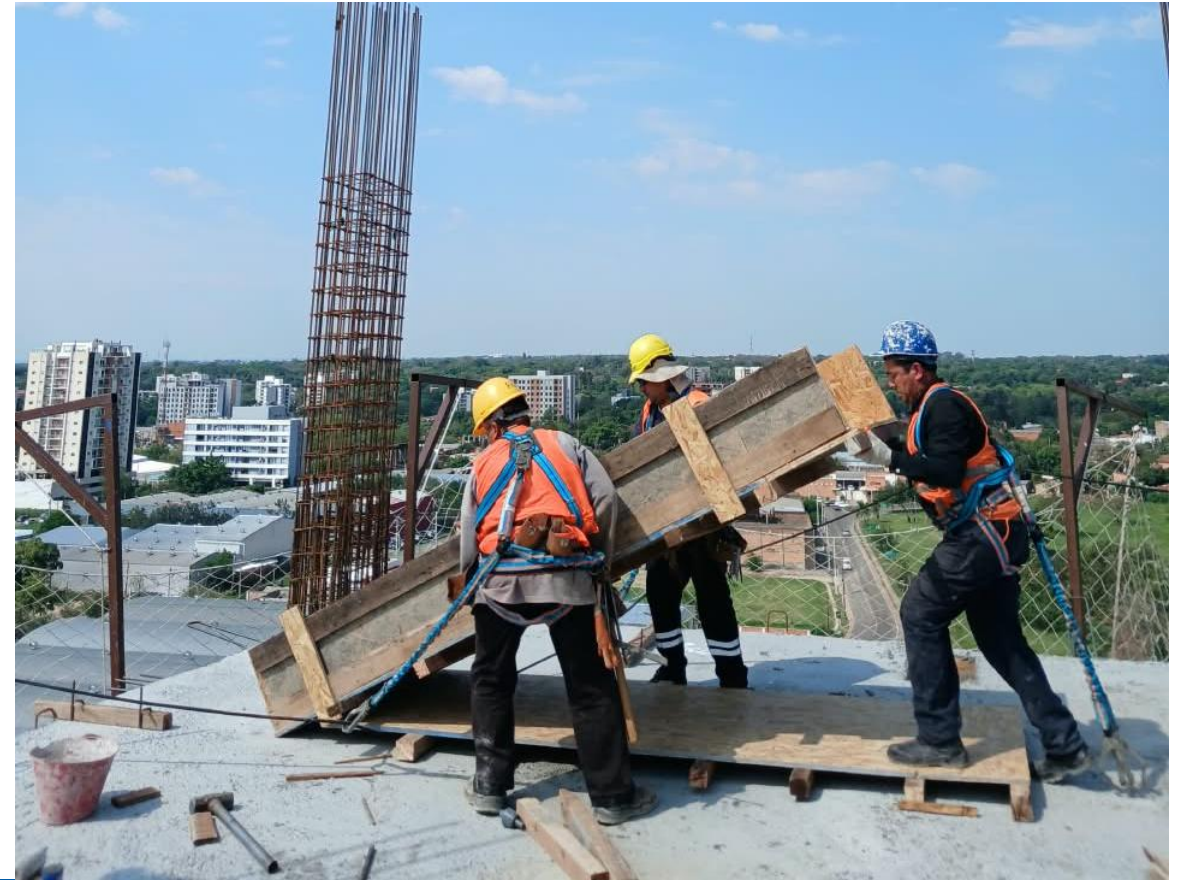
Encofrado de pilares para cargamento Nivel 12 en Torre 20
