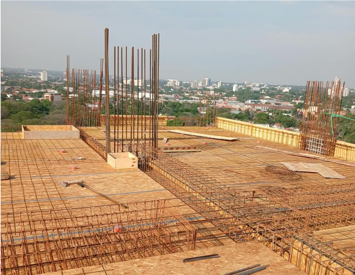
Trabajos de encofrado y armado de losa de azotea en Torre 21
