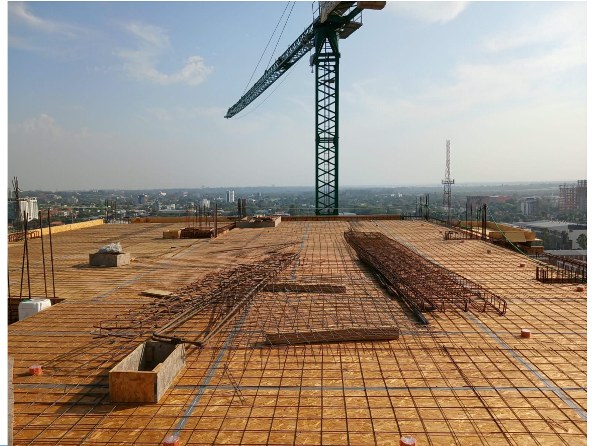
Trabajos de encofrado y armado de losa de azotea en Torre 21
