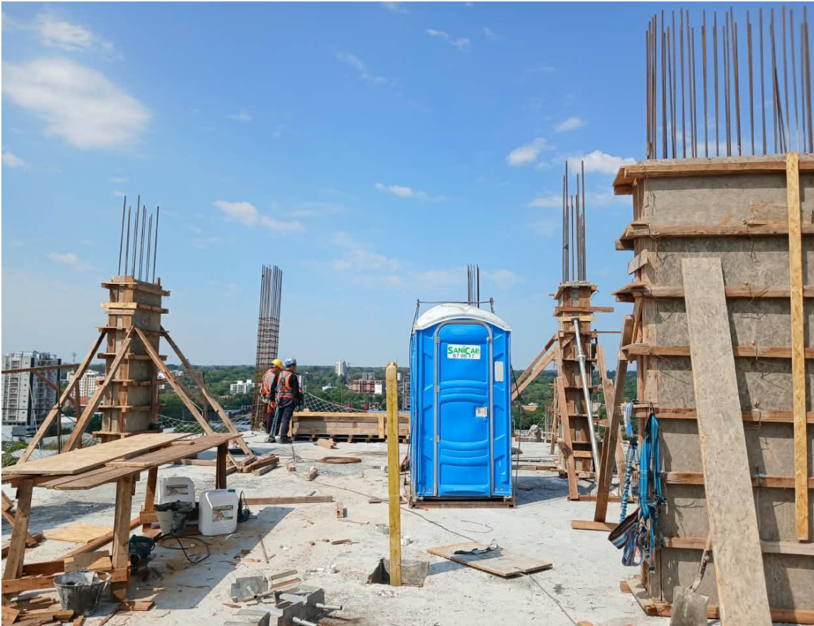
Encofrado de pilares para cargamento Nivel 12 en Torre 20
