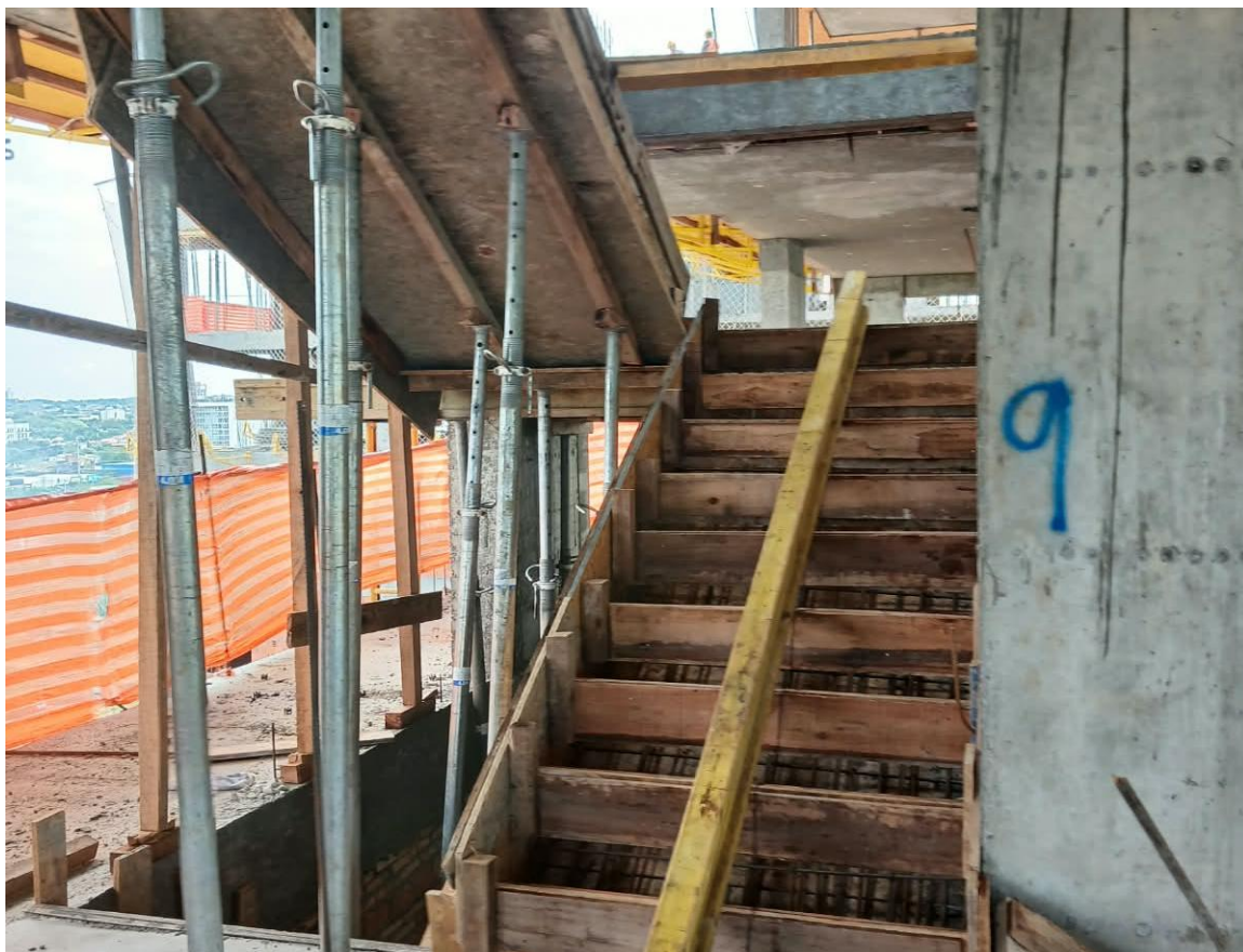
Trabajos de encofrado de escalera y de instalaciones eléctricas en Torre 21
